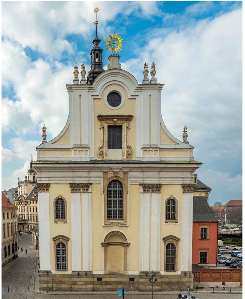
Kościół uniwersytecki pw. Imienia Jezus, Wrocław. Fot. Dorota i Andrzej Niedźwieczi.
